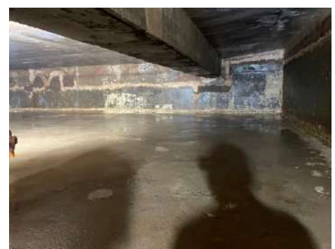
สภาพภายในถังหลังการเก็บเศษตะกอน
