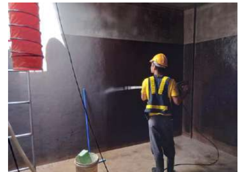
การทำความสะอาดพื้นด้วยปืนฉีดน้ำแรงดันสูง
