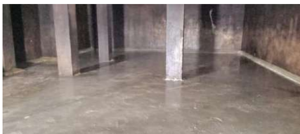
สภาพภายในถังหลังล้างเสร็จ
