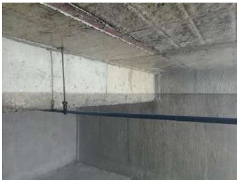
สภาพภายในถังหลังล้างเสร็จ
