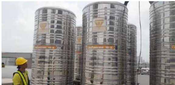
ถังบนอาคาร
