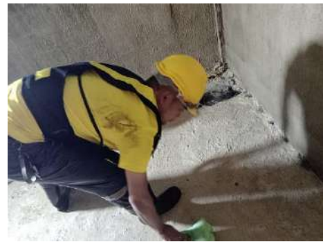
สภาพภายในถังหลังล้างเสร็จ
