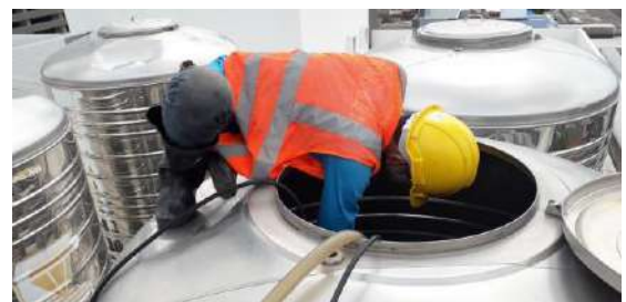
สภาพภายในถังหลังการเก็บเศษตะกอน
