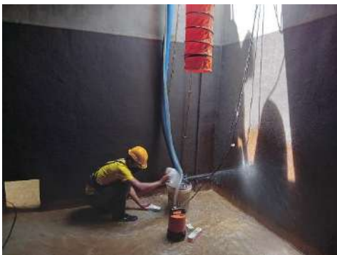
สภาพภายในถังและการดูดตะกอน
