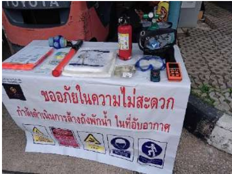
การวัดขนาดถังจริงในพื้นที่ทำงาน
