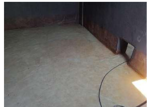
สภาพภายในถังหลังการทำความสะอาด
