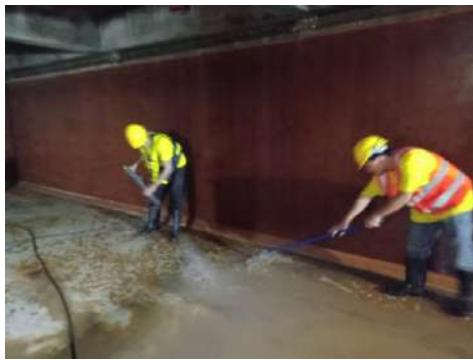
การทำความสะอาดผนังด้วยปืนฉีดน้ำแรงดันสูง
