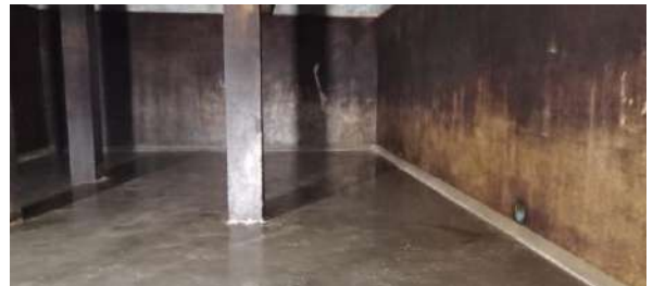
สภาพภายในถังหลังล้างเสร็จ
