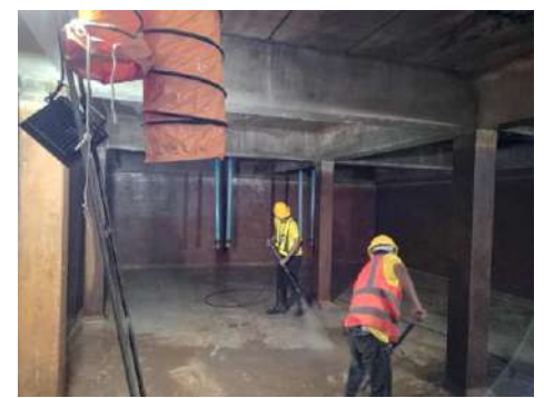
การทำความสะอาดพื้นด้วยปืนฉีดน้ำแรงดันสูง
