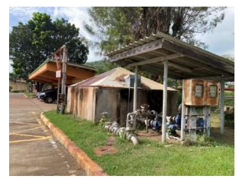
สภาพภายในพื้นที่ทำงาน
