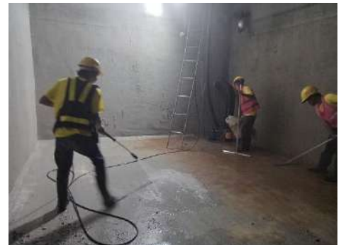
การทำความสะอาดผนังด้วยปืนฉีดน้ำแรงดันสูง
